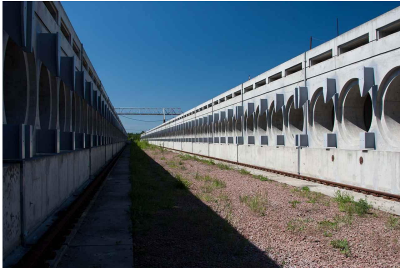
Oberirdischer Lagerplatz für die abgebrannten und danach konditionierten Brennelemente.
