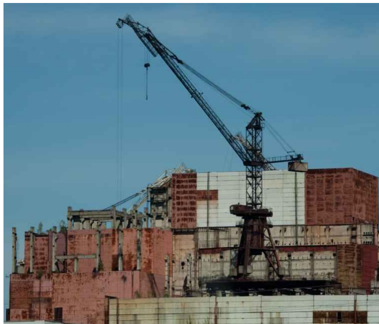
Bauruine der Kraftwerkseinheiten 5 & 6.
