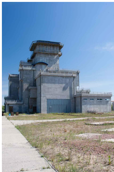
Hotzelle im Bau für die Verarbeitung der abgebrannten RBMK-Bennelemente.
